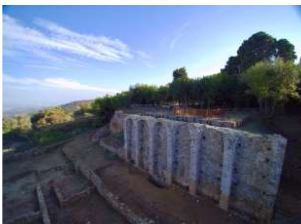
Fig. 1 - L'edificio romano delle Logge (Populonia)
